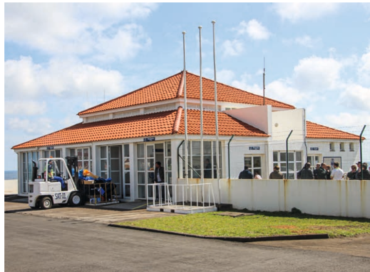
Das Abfertigungsgebäude gestattet nur die notwendigen Abfertigungsprozesse. Shops oder ein Café sucht man vergebens
