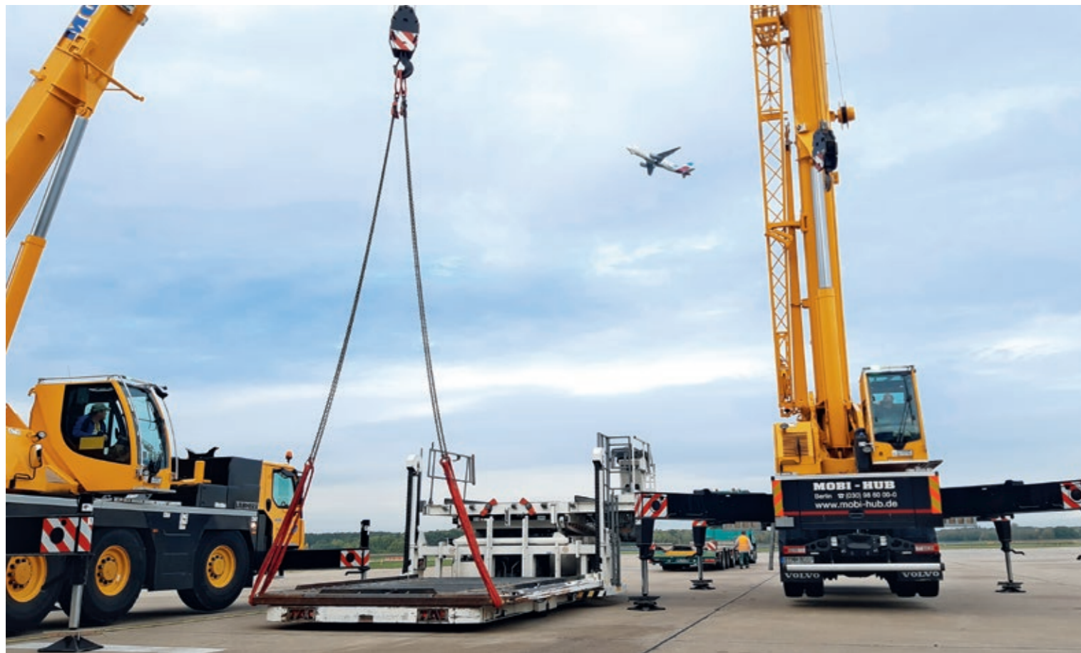
Der knapp 19 Tonnen schwere Highloader musste mithilfe von Kränen verladen werden
